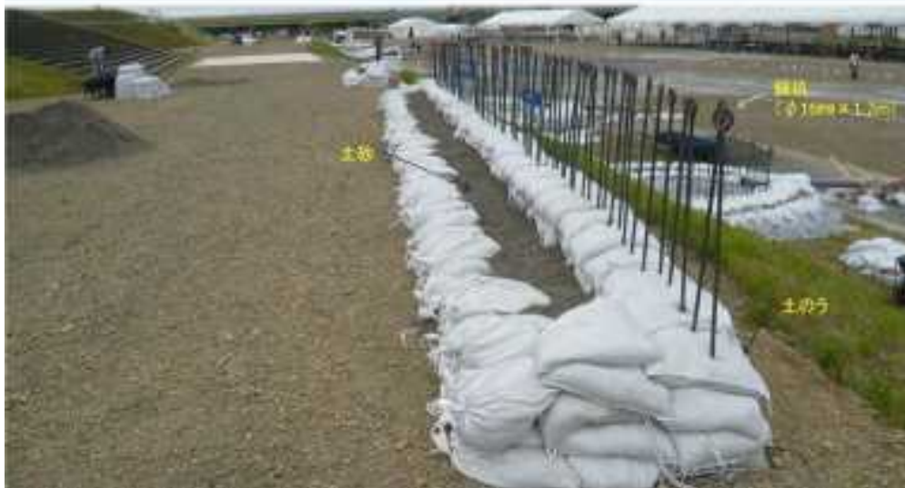
⑤ 積土のう工(10m)
