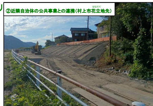
地すべり対策事業(押え盛土)への土砂提供(図6-4)
