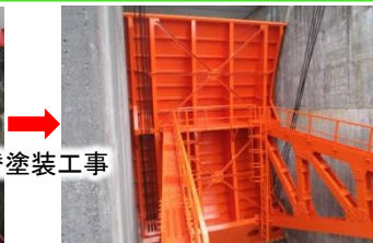
非常用放流設備塗替後(大石ダム)
