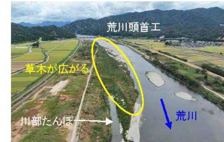
荒川頭首工下流右岸 (R5撮影)
