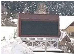
川口橋放流警報表示板 更新(大石ダム)
