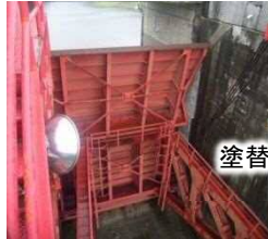
非常用放流設備 塗替前(大石ダム)
