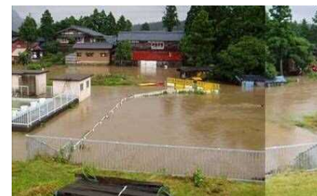
H16(2004).7.17出水時(内水による床下浸水3棟)
