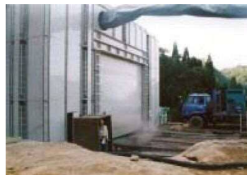
トンネル発破作業防音壁
