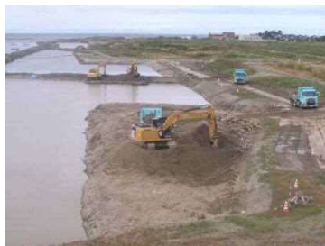
【羽越河国:ハード対策】 流下能力向上を目的とした 河道掘削 (村上市海老江地区)
