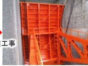
非常用放流設備 塗替後(大石ダム)
