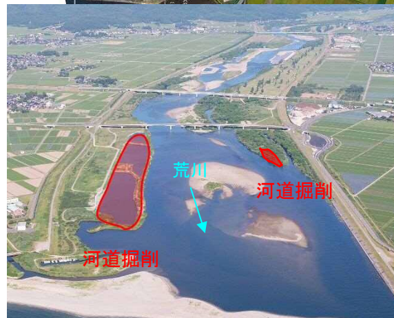
河道掘削状況(撮影:R1.6)
