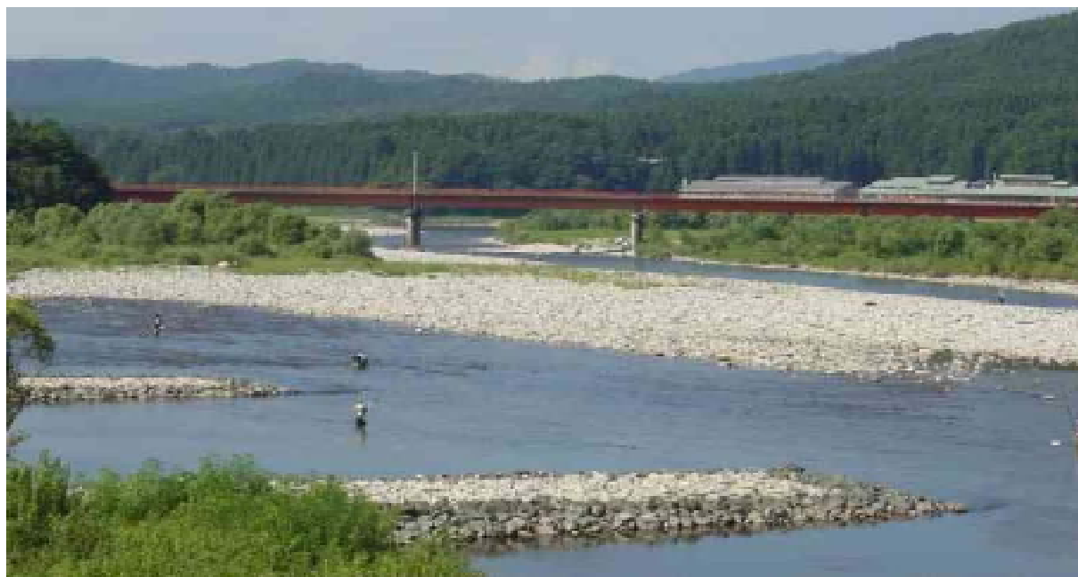
図 - 1 6 雲母地区水制の設置状況
