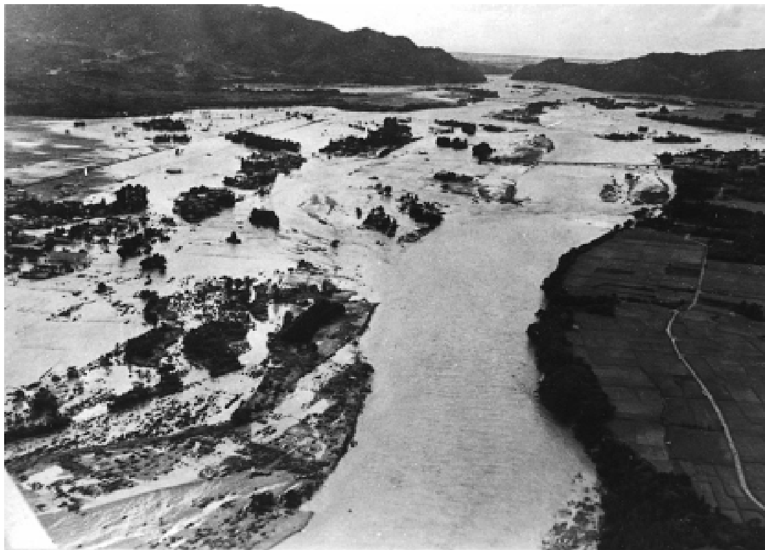
図 - 5 羽越水害の被害状況（関川村上空より下流を望む。）
