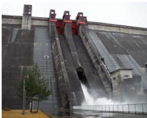
図 - 2 1 大石ダムの放流状況
