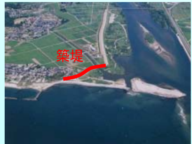
築堤位置写真
