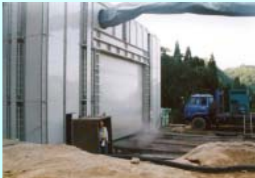
トンネル発破作業防音壁
