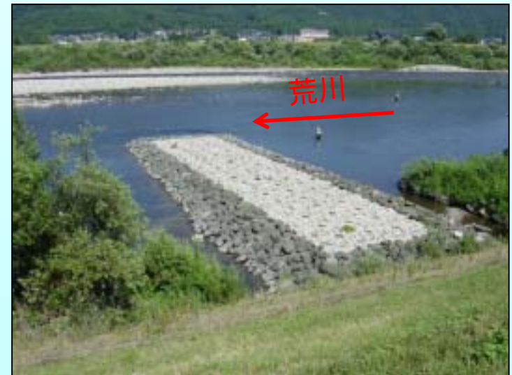
H13年度に設置した水制工の状況
