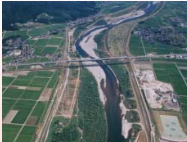
JR羽越本線荒川橋梁下流附近
