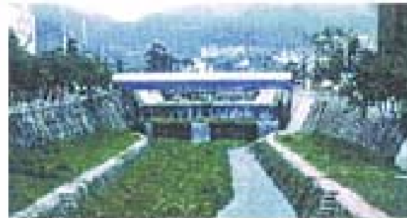
床止め(落差工)
