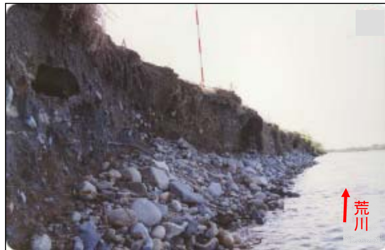
河岸侵食の事例(H4年:荒川町荒川縁新田地先)
