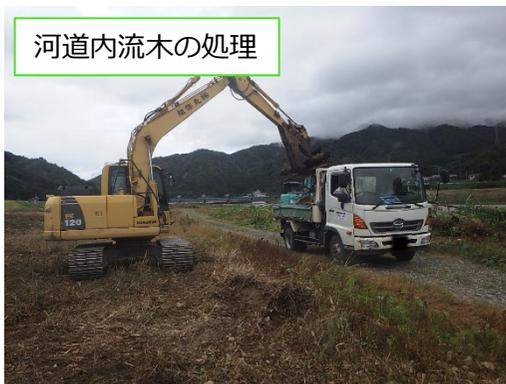
出水等により流下し河道内に堆積した流木は下流施設に影響を与える恐れがあるため回収搬出。
