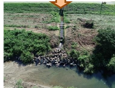
排水樋管の堤外水路は草木の繁茂により排水機能に支障があるため伐採作業を実施。
