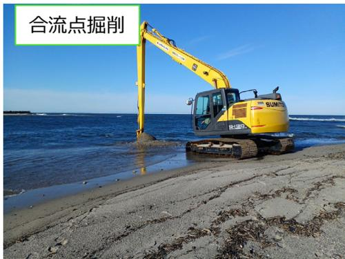
堀川河口の荒川との合流点は、土砂埋没しやすく、河口が閉塞する原因となることから、河道確保の為に掘削を実施。
