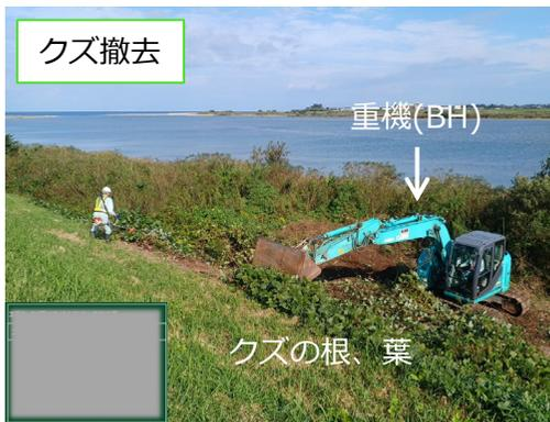
一面に繁殖したクズが護岸目地に侵入して損傷の原因になっている他、堤防護岸の点検に支障があるため、計画的な撤去を実施。
