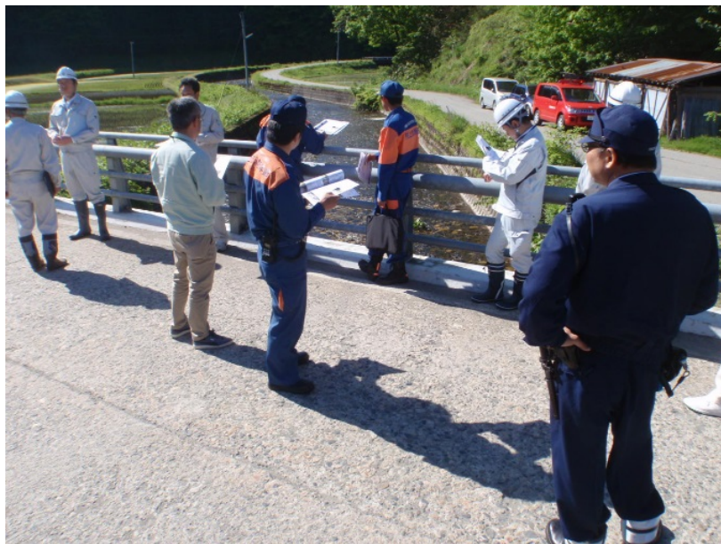
重要水防箇所の点検状況
