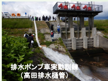
②排水ポンプ車実働訓練
