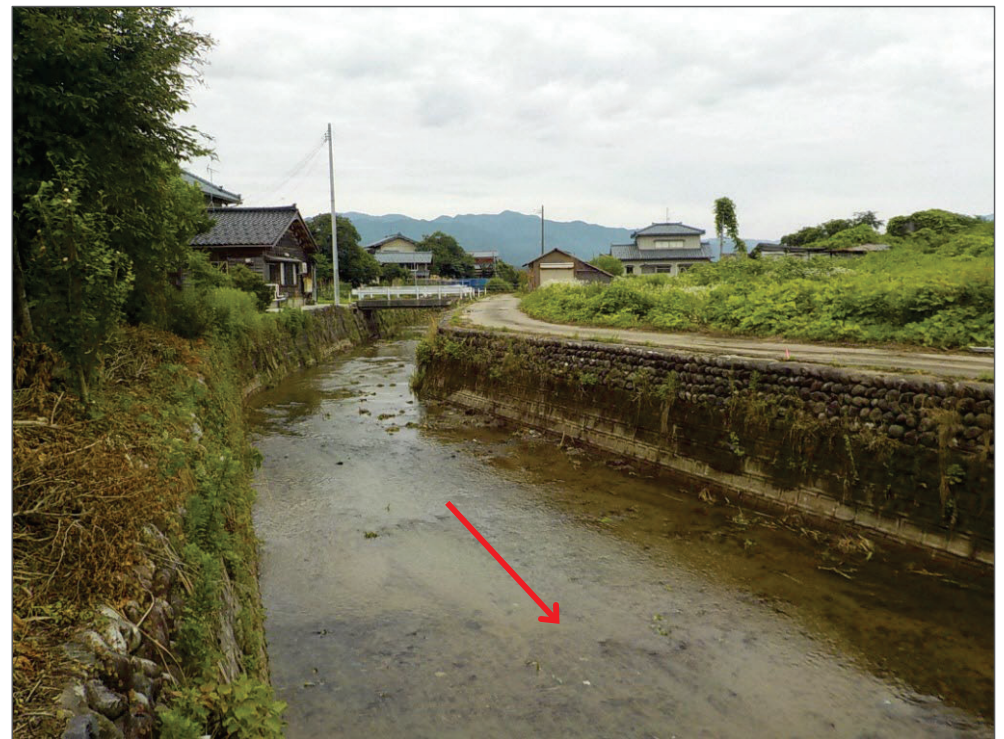
河床掘削工事 完了後
