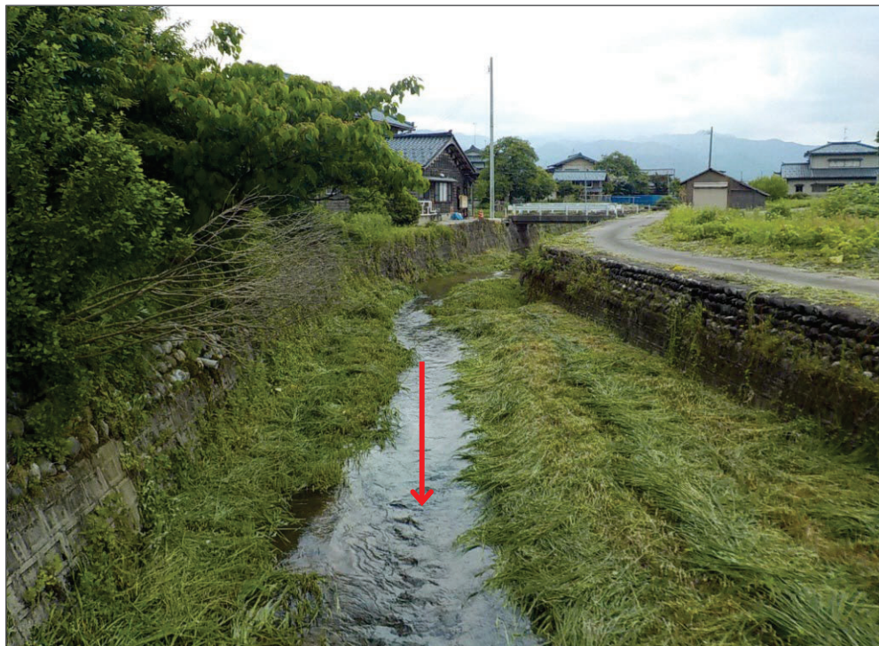
河床掘削工事 着手前
