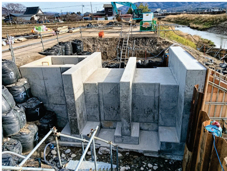
烏川1-2 樋門整備状況
