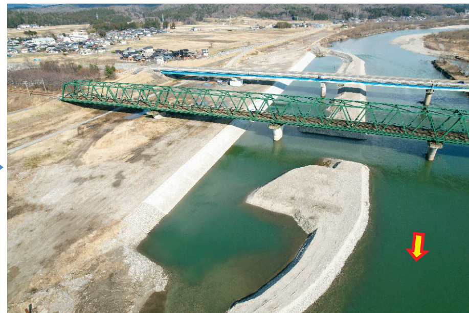
河川低水護岸工事完成(R7.3)
