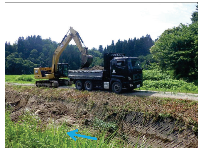
田沢川(小国町田沢頭) 河道掘削状況
