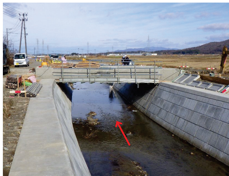
市道橋架替え工事実施状況(令和7年12月撮影)
