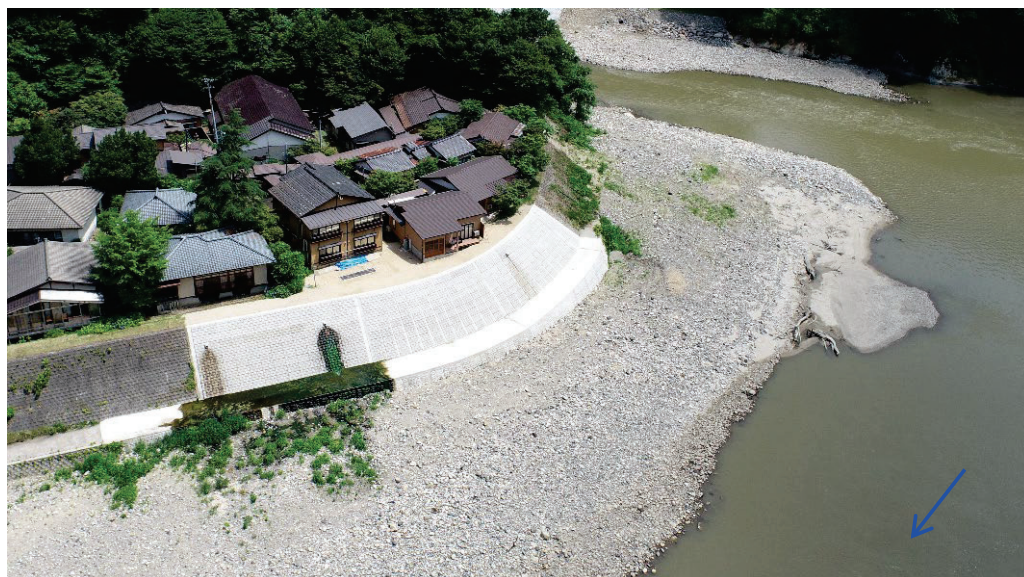
災害復旧工事完了状況(R7.7)
