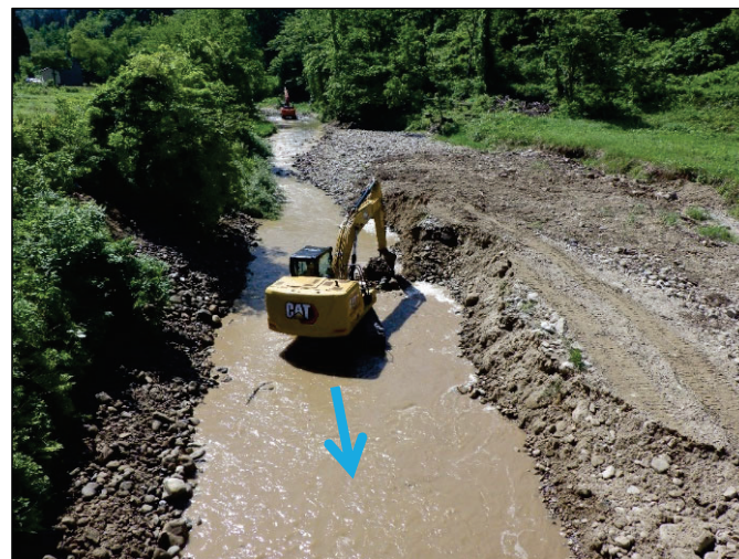
石滝川(小国町石滝) 河道掘削状況
