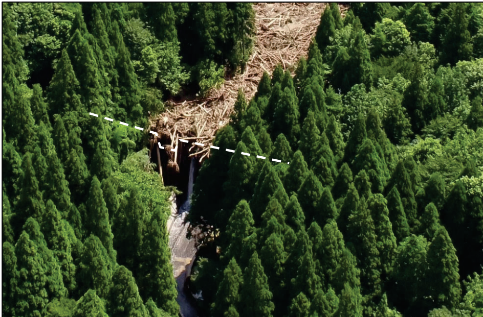
荒川水系 小岩内大沢川(砂防河川) 村上市小岩内 着手前
