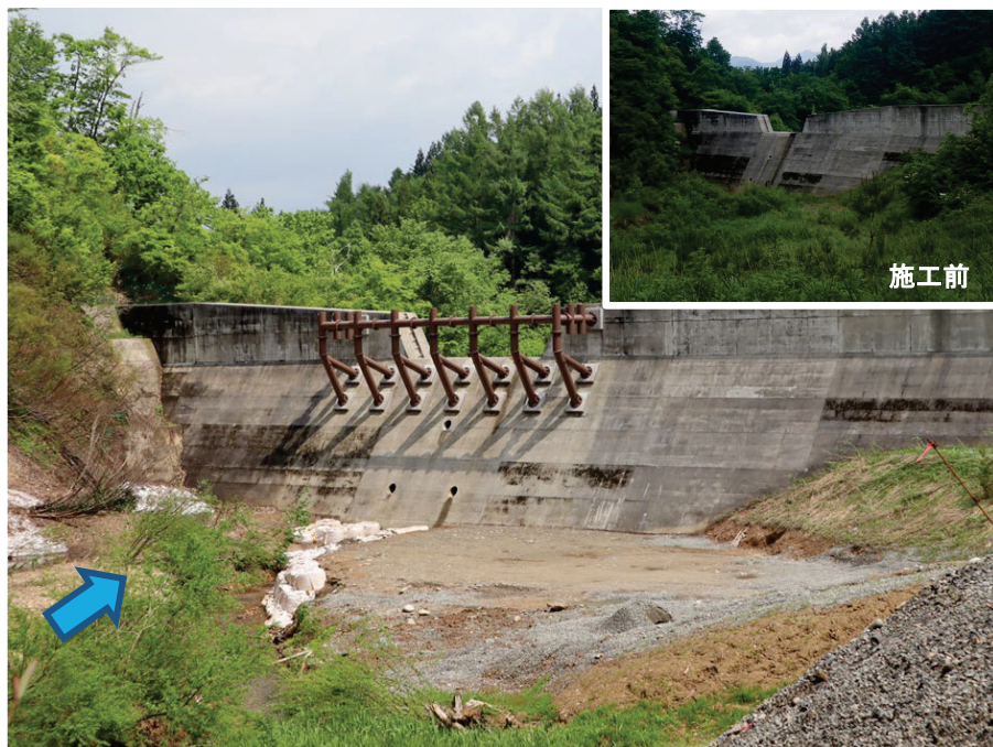
枯松沢砂防堰堤(小国町) 流木対策工施工完了
