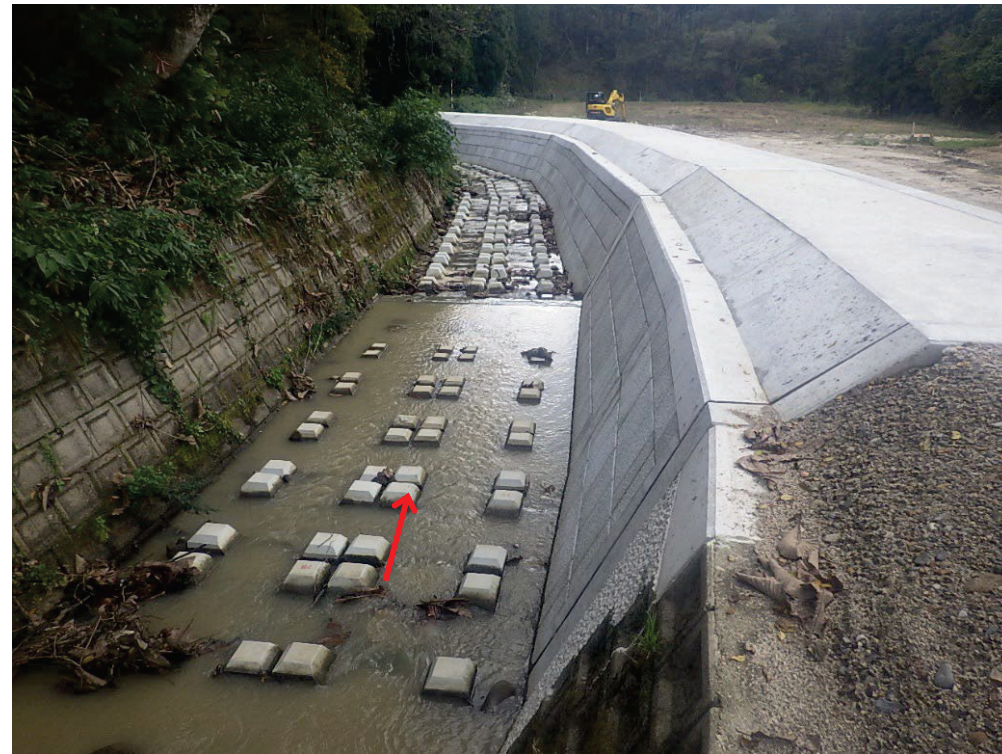
災害復旧工事 完了後
