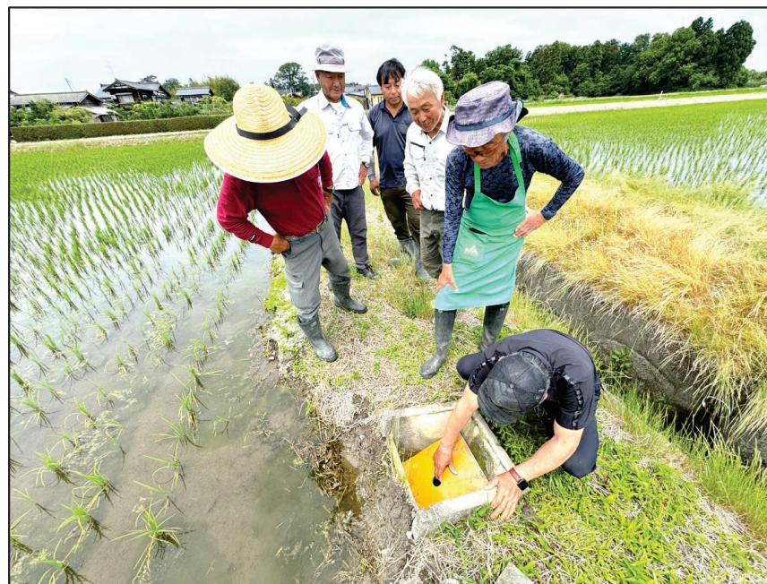
田んぼダム：排水調整板(落ち蓋)設置状況
