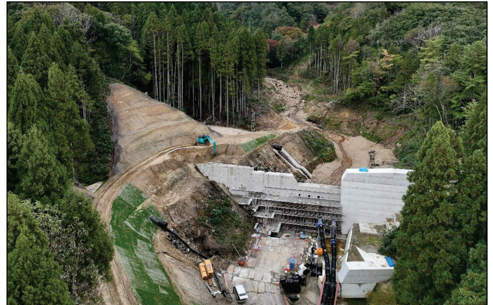
流木撤去・除石完了 手前は災害関連緊急砂防事業堰堤嵩上げ(工事中R6.11)
