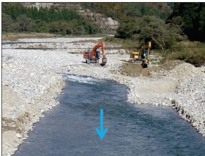
荒川(小国町長沢) 河道掘削状況
