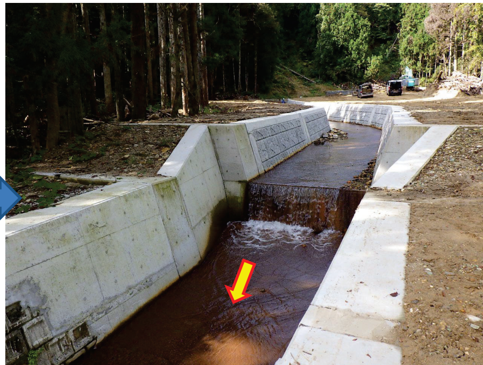
河川災害復旧工事 完了( R6. 11 )
