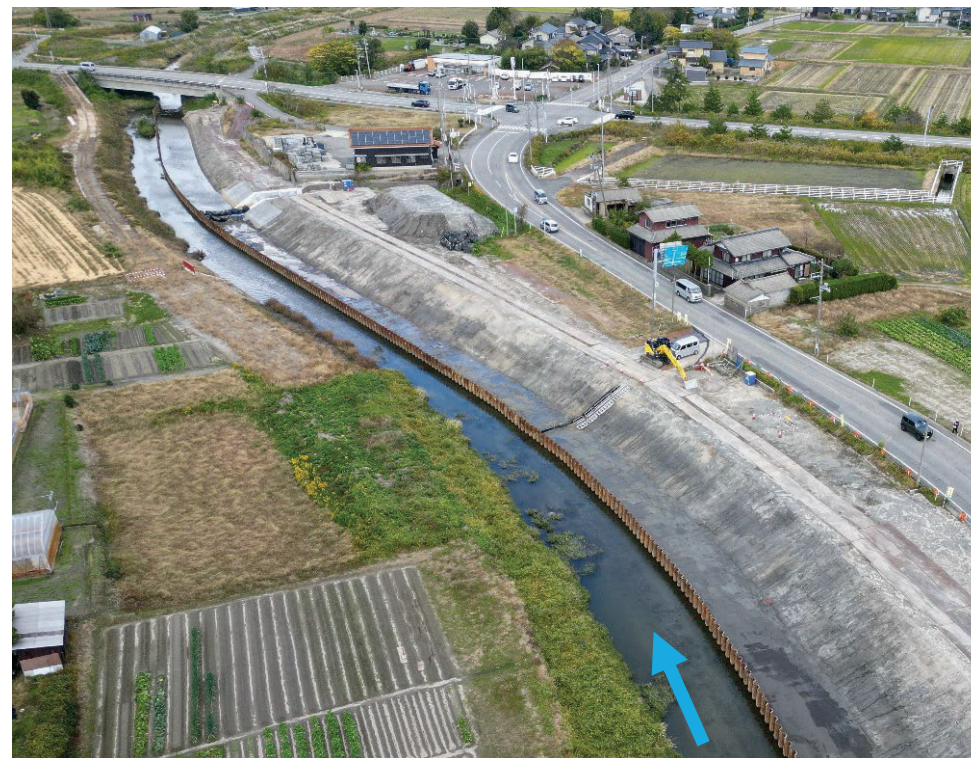
河川改修工事 施工状況(令和7年11月撮影)
