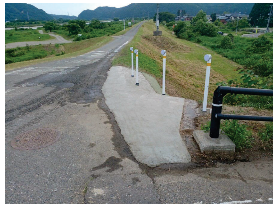
高田橋橋詰め 回転場の整備
