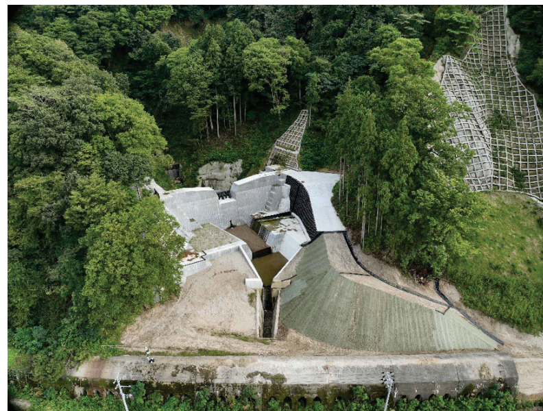
念仏沢川砂防堰堤竣工(R7.11)
