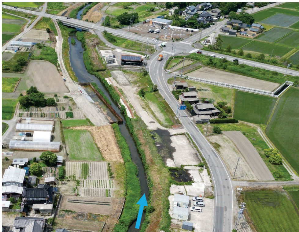
河川改修工事 (令和7年6月撮影)
