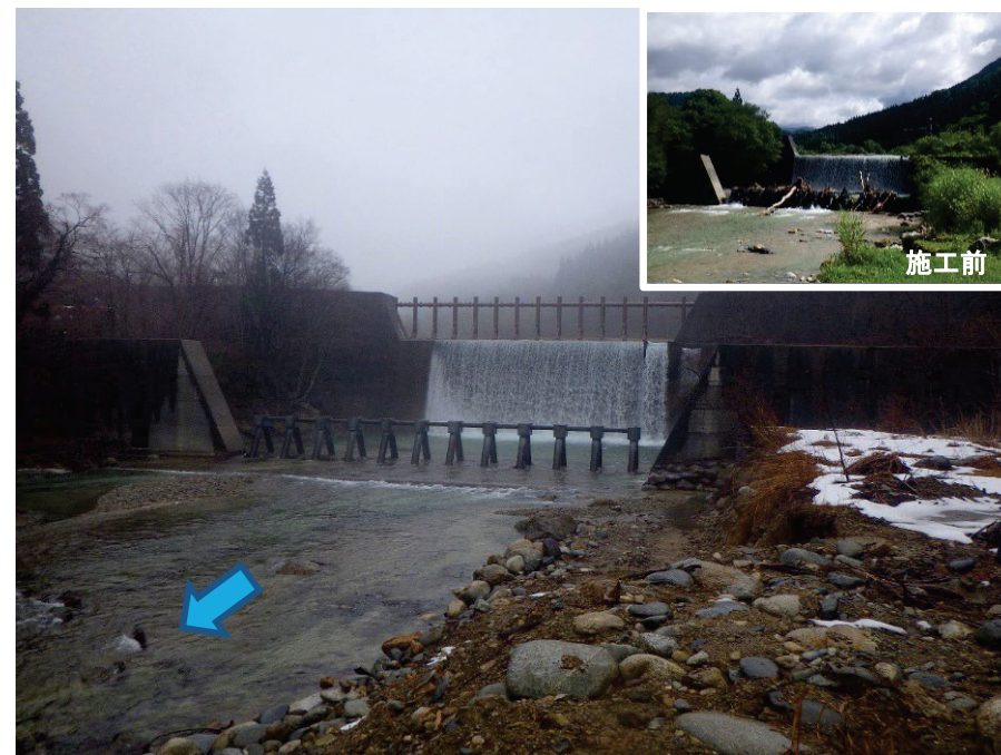
穴淵砂防堰堤(小国町) 流木対策工施工完了
