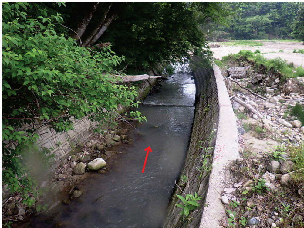
災害復旧工事 着手前
