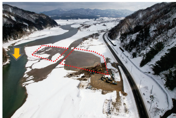
貝附地区(R8. 2撮影) 農水省・県・自治体・水利利用者・河川利用者の協力を得ながら荒川頭首工のゲートを開け、貯水池の水を抜いた状態で、河床掘削を行っております。
