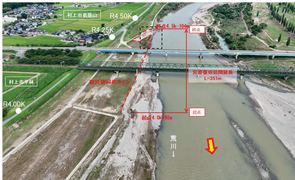
R4.8出水後の被災状況(河岸侵食)
