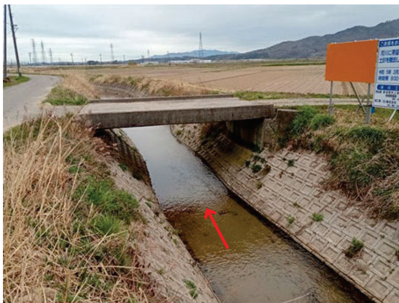
市道橋架替え工事 着手前
