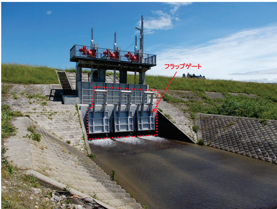
フラップゲート設置状況(令和6年3月完成)
