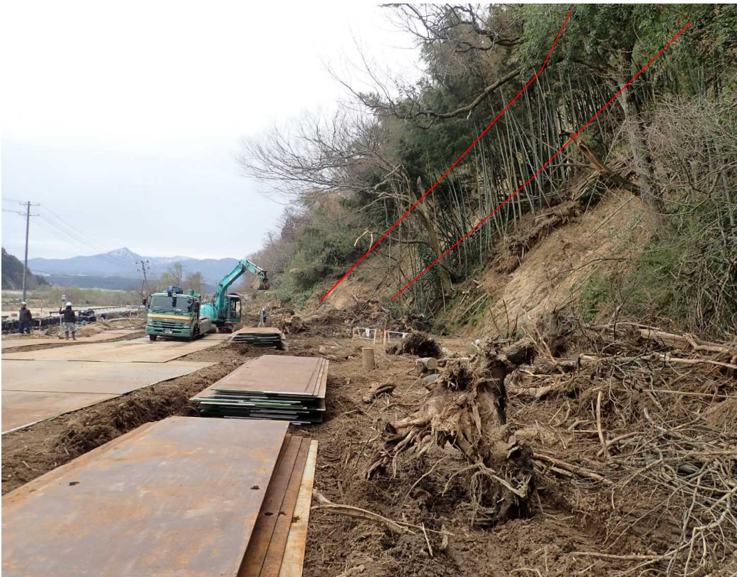
貝附地区、施工状況(準備工、工事用道路)
