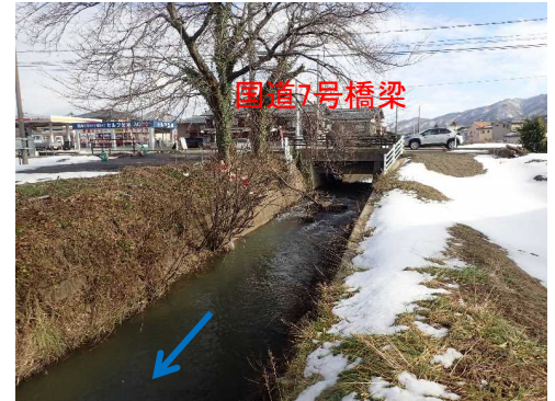
春木山大沢川国道7号橋梁(設計実施中)
