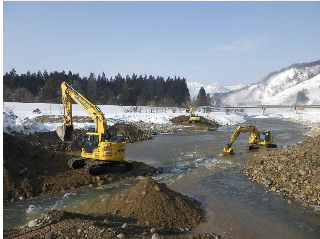
荒川(小国町長沢) 河道掘削状況
