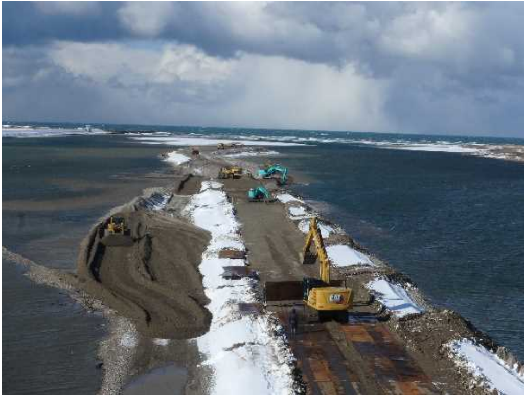
荒川(村上市海老江) 河道掘削状況
