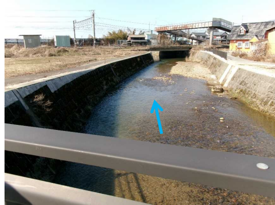
烏川(電波式水位計設置予定)
