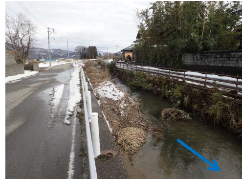
春木山大沢川河道掘削工事箇所
