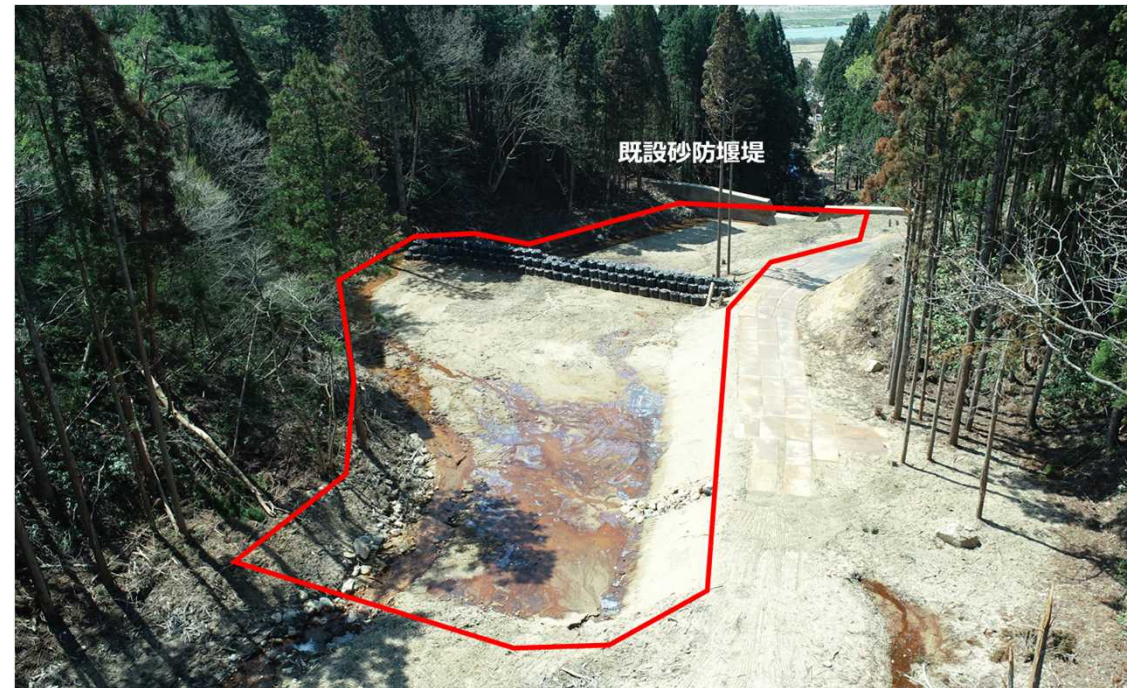
小岩内大沢川 除石(令和5年4月時点)
