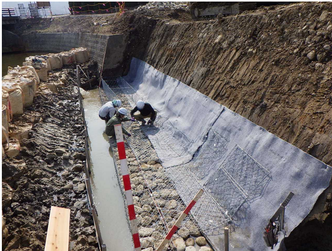
一級河川烏川 4災河第240号 護岸工施工状況
