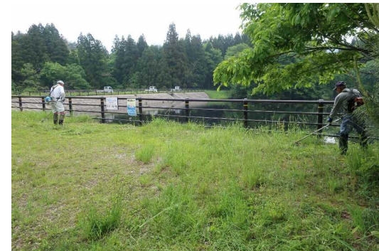
堤体の草刈り
