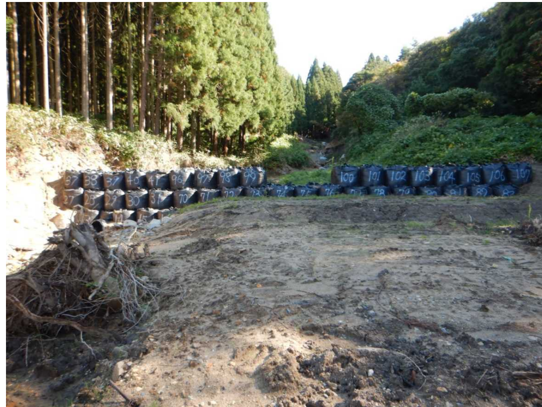
村上市小岩内地区 応急大型土のう設置完了(令和4年10月)
