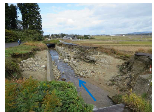
春木山大沢川国道113号上流 災害復旧工事箇所
