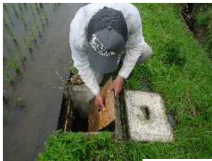
落水調整板の設置・更新
