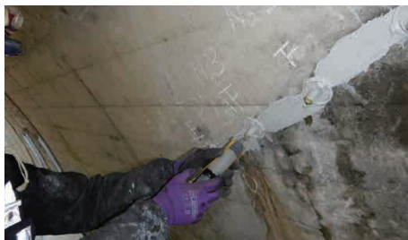
トンネルのひび割れ補修
