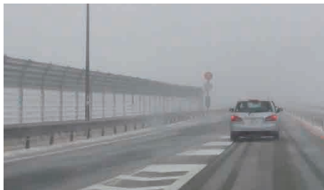
地吹雪防止柵の設置
