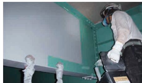
橋梁の塗装塗り替え
