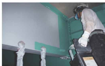
橋梁の塗装塗り替え
