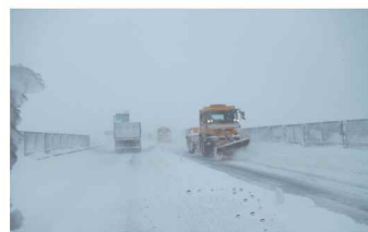
道路除雪(日東道)
