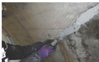
トンネルのひび割れ補修
