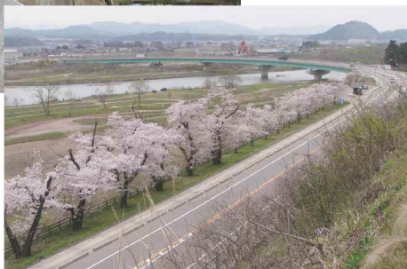
国道7号(三面川付近)
