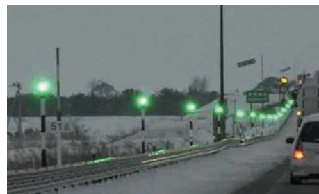
自発光式視線誘導標の設置状況
