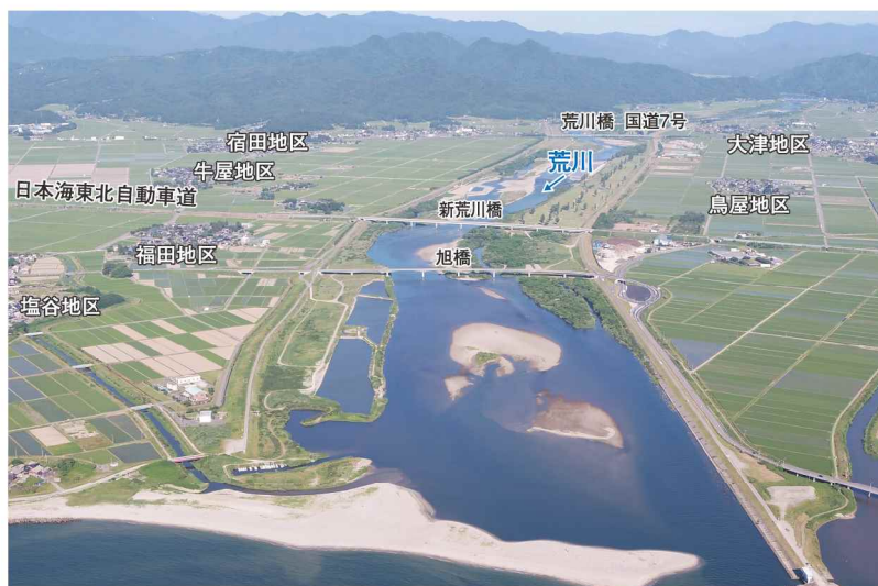
河道掘削(海老江地区)
