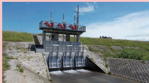
高圧排水樋管フラップゲート化
