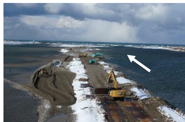
河道内掘削 (荒川左岸0.25k付近)
