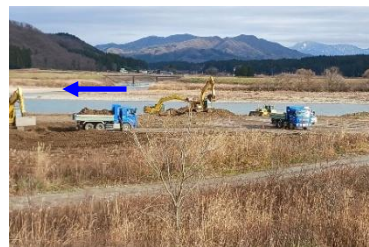
河道内掘削 (荒川左岸10.75k付近)
