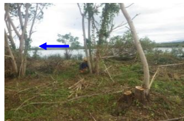
樹木伐採 (荒川左岸1.25k付近)
