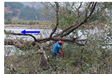
樹木伐採 (荒川左岸10.75k付近)
