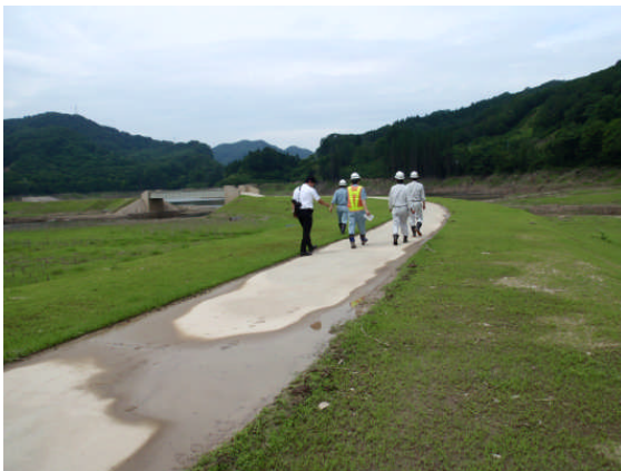
横川ダム 不動出生橋周辺を点検
