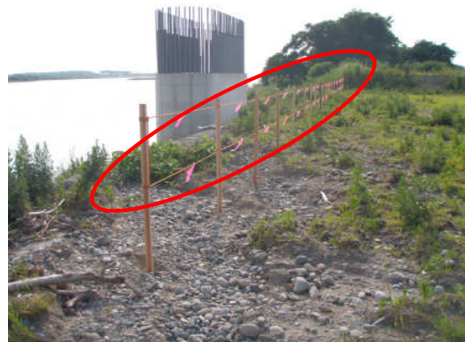
水辺への転落の危険性がある箇所にはロープ柵を設置するなどの対策を実施
