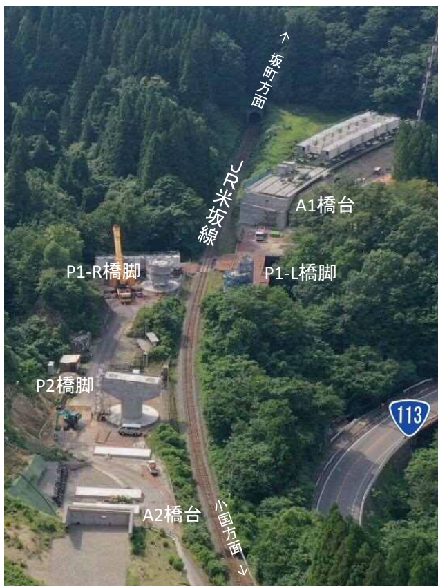
鷹ノ巣道路1号橋梁全景 下部工完成 令和2年8月撮影
