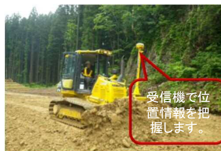
②大内淵地区 盛土作業状況
