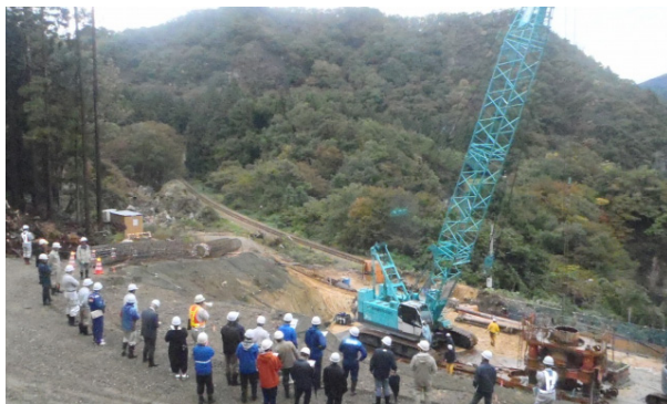
掘削中の杭基礎を見学
