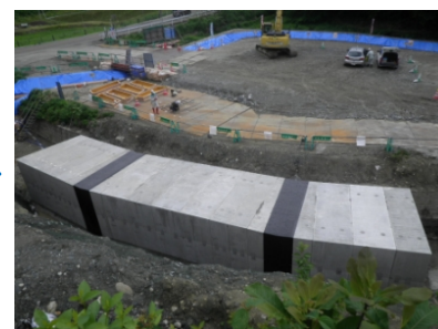
ケーブルで締め付けて連結させます
