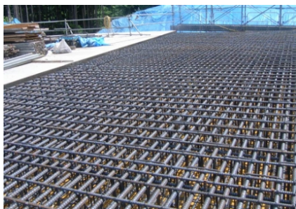
【正確に組み立てられた鉄筋】
