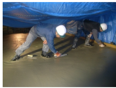
【丁寧なコンクリート表面仕上げ】
