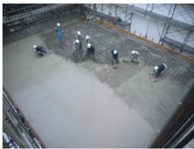
【チームワークのコンクリート作業】
