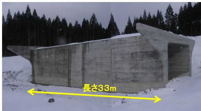
コンクリートは全部で約2,700m 3
