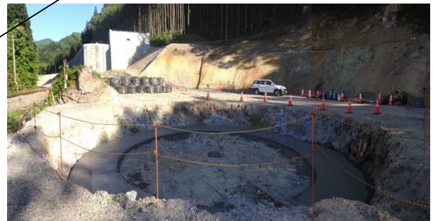
P2橋脚掘削状況写真 5/18現在
