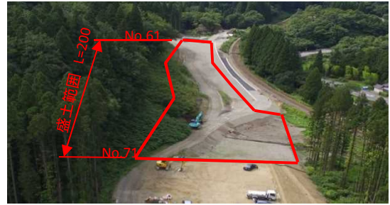
施工範囲イメージ写真(大内測地区)
