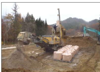
土質改良機で石灰と土砂を混合します
