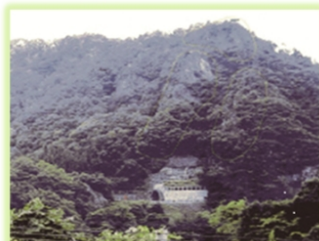
【落石崩壊等の危険箇所】
