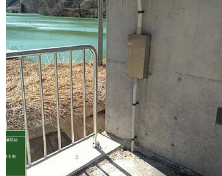
■ 転落防止のロープ柵設置 (艇庫周辺・小国町)
