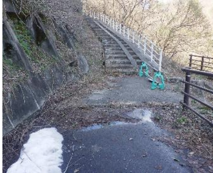
■ 立入禁止区域の柵・看板設置 (左岸下流公園・関川村)
