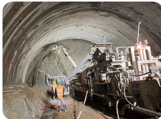
【掘削時の状況】
