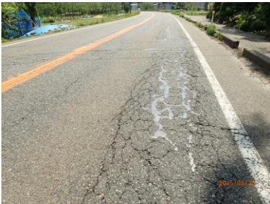
舗装のひび割れ
