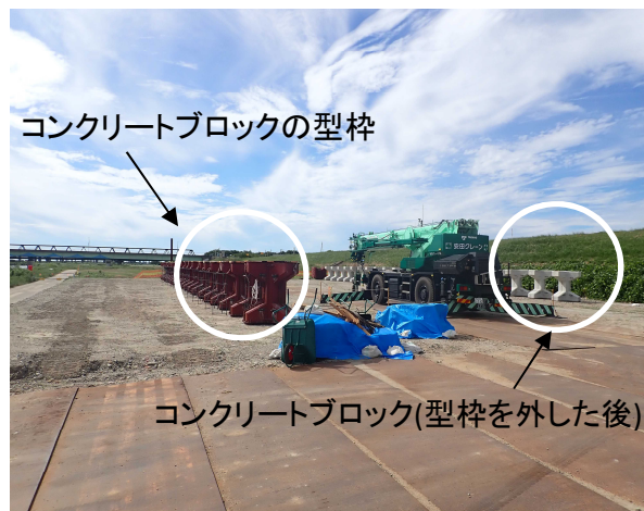
コンクリートブロックの製作状況 (8月8日状況)
