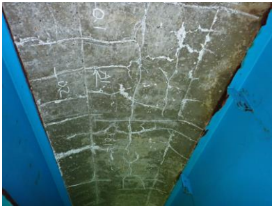
橋の裏面の様子 (床版のひび割れ)
