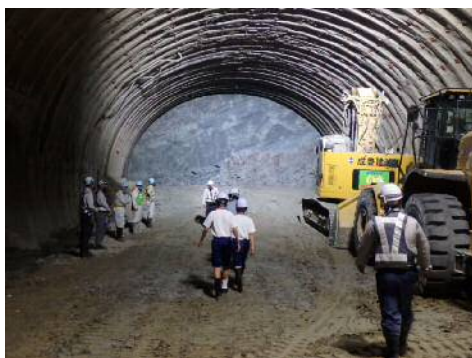
トンネル内部見学
