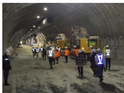
トンネル内見学の様子
