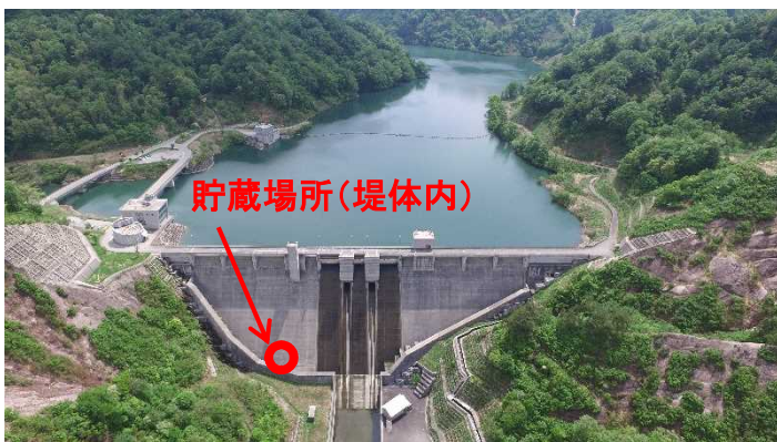
横川ダム全景
