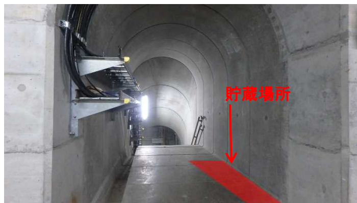
ダム監査廊内(最下層)
