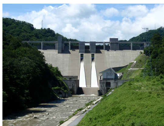
▲オリフィスゲートからの放流（6月10日以降の増水時） ダム正面（展望広場）から撮影
