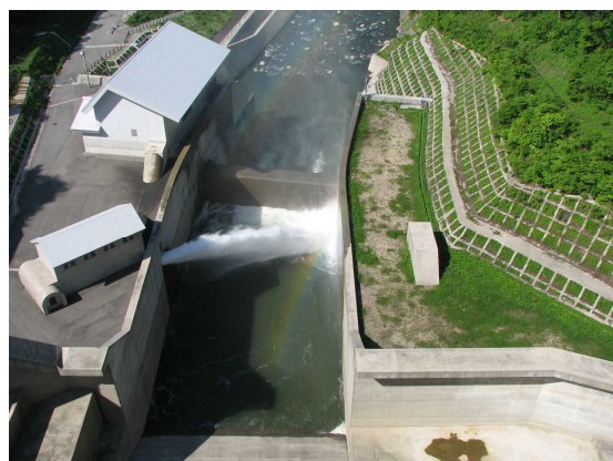
▲利水放流設備からの放流（通常時） ダム天端から撮影
