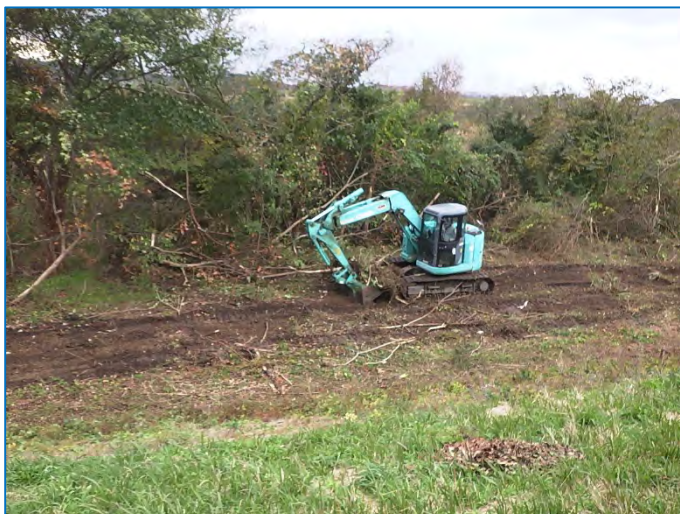
伐開作業中 (村上市川部付近)
