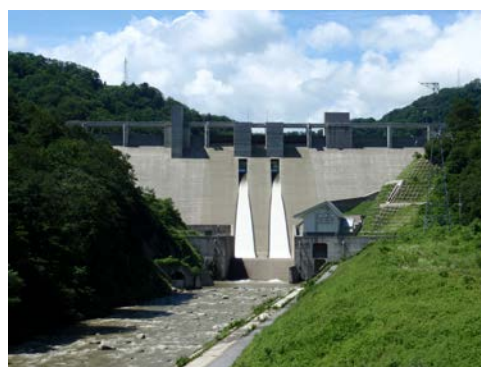
▲オリフィスゲートからの放流
