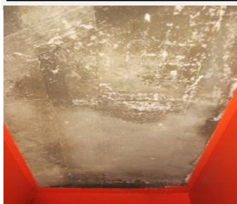
橋の裏面の様子 (床版のひび割れ)
