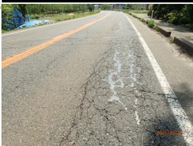
舗装のひび割れ
