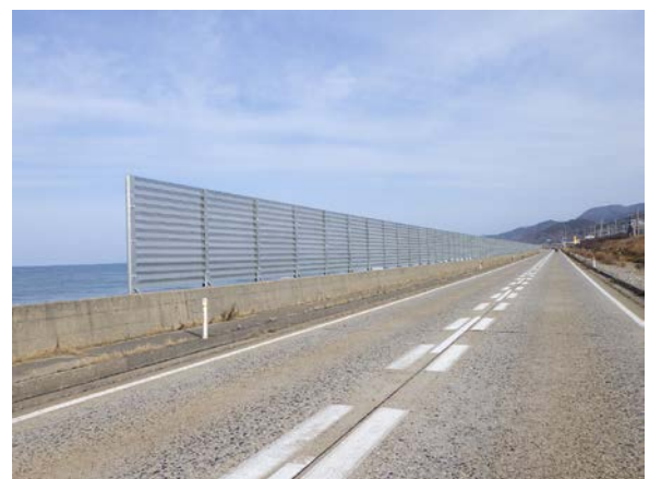
完成した波しぶき防止柵
