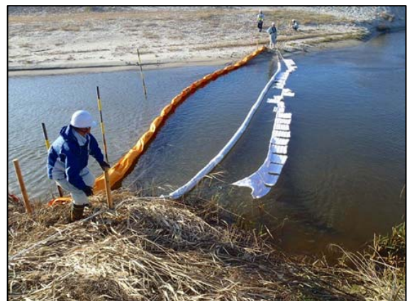
タイプ別のオイルフェンス設置状況（H26）
