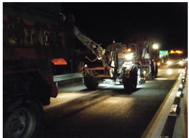
【夜間集中工事状況】
