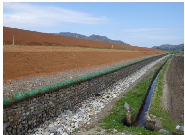
【ドレーン完成状況】
