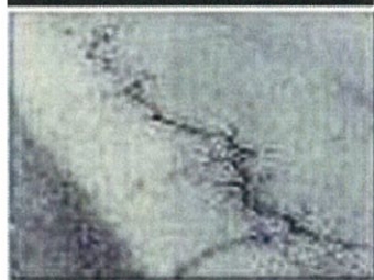
舗装のひび割れ
