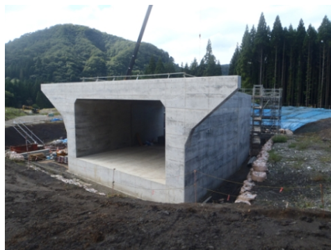
【鷹ノ巣道路沿地区改良その2工事の状況】
