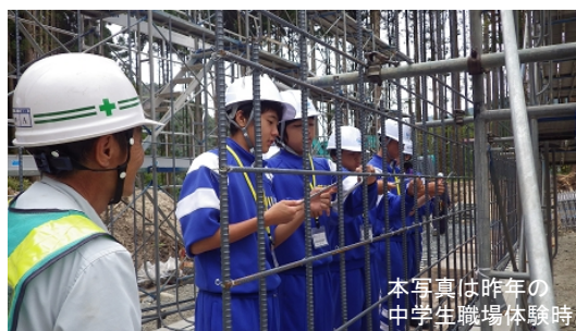
【鉄筋結束作業体験】
