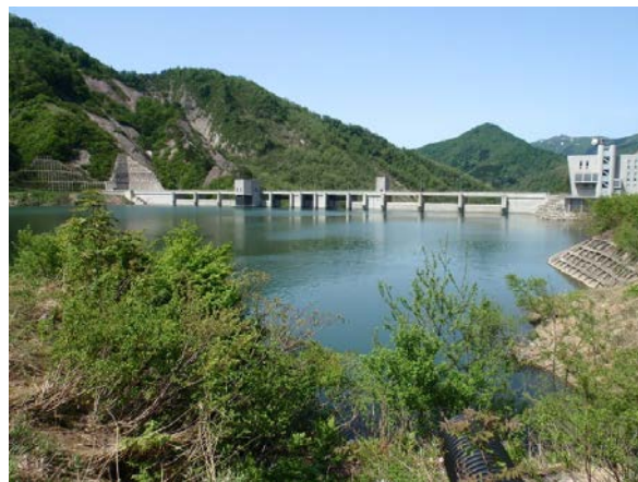
（今年〈5月19日〉の貯水位を下げる前の状況）
