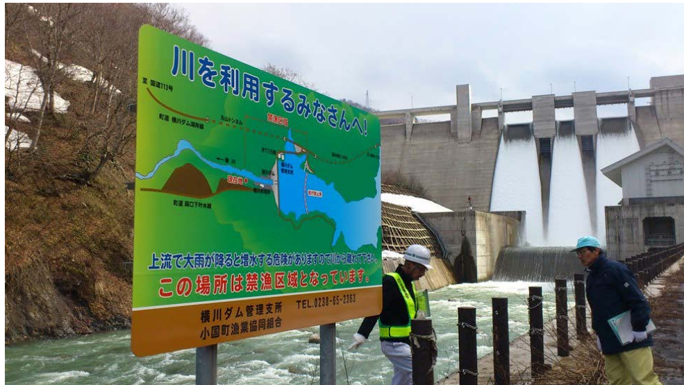
(昨年(4月19日)の点検状況)
